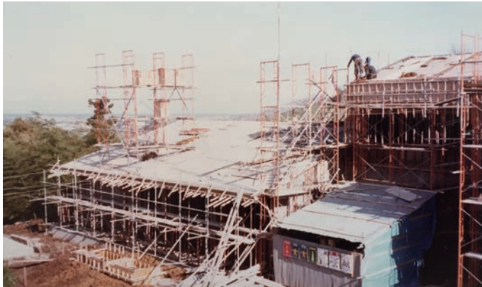
建設中のうさか寮
