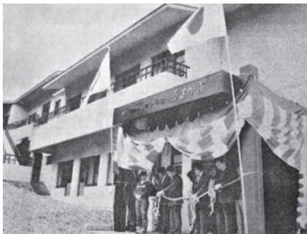
1983年「うさか寮竣工式」でのテープカット。
