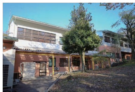
大規模修繕工事を終えた現在のうさか寮。性別や個々の特性に配慮し、4つのユニット（棟）に分かれている。
