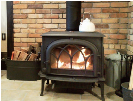
薪ストーブはその暖かさに加え、レトロなインテリア感や、炎の揺らぎによるリラックス効果にも注目されています。
